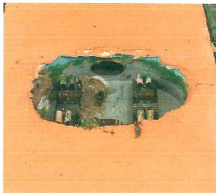
Foto 2: Rerapación de sistema eléctrico
