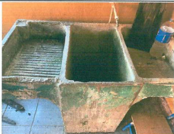
Foto 1: Mejoramiento de red agua potable
