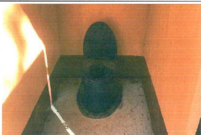
Foto 3: Reparación de servicios sanitarios
